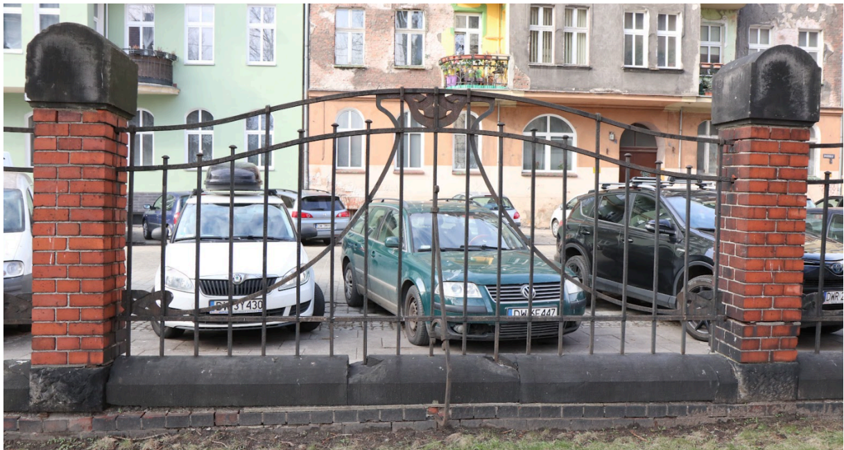
zdj. nr 4 - zdjęcie z realizacji, przykład istniejącego ogrodzenia Typ 1
