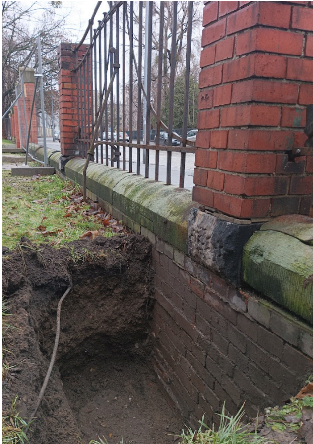
zdj. nr 3 - zdjęcie z realizacji, przykład istniejącego fundamentu
