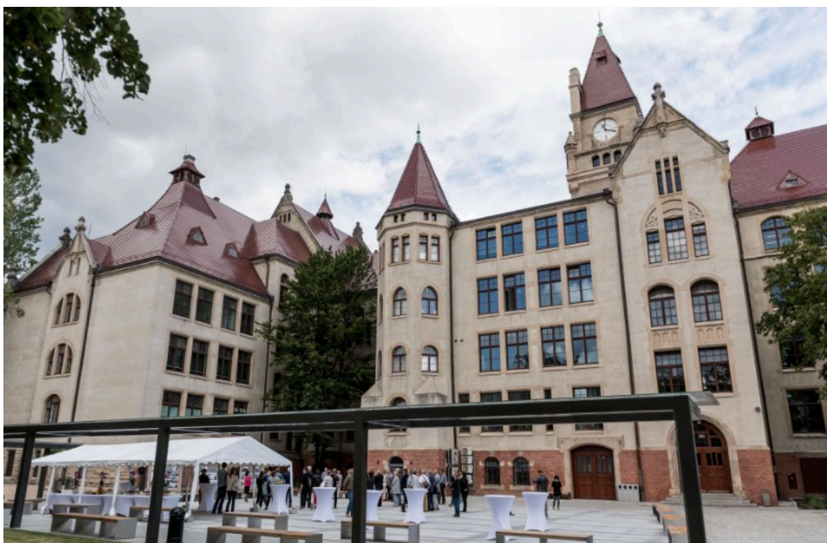
zdj. nr 1 - budynek E1, widok od strony dziedzińca
